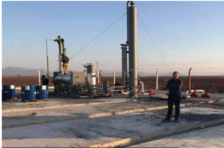
Adana Paşaoğlu Doğal Gaz Boru Hattı ve Yüzey Tesisleri
